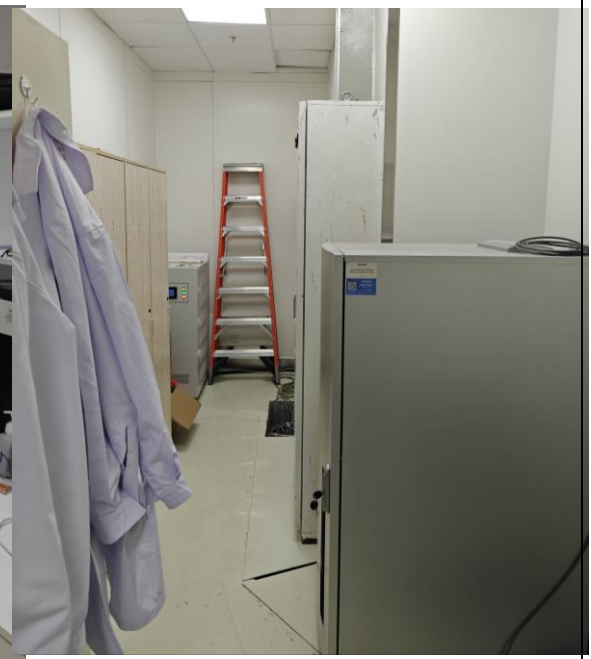
东侧设备机房
