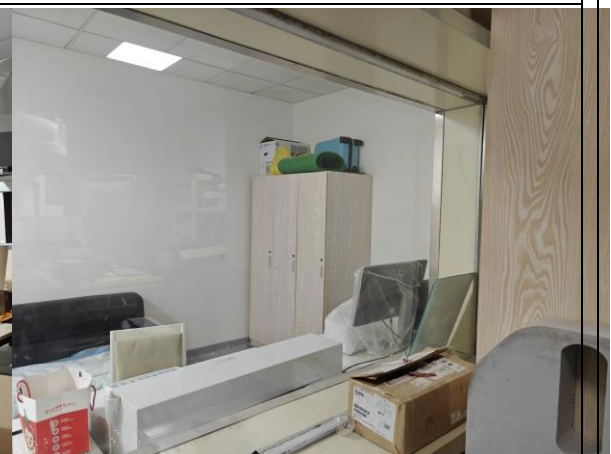
西侧模拟定位机房操作间
